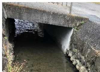
▲用水路の補強(額田地内)
