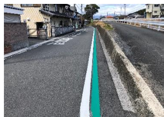
▲グリーンベルト設置(西別所地内)
