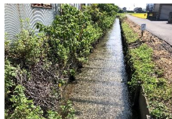
▲用水路の土砂撤去清掃(増田地内)
