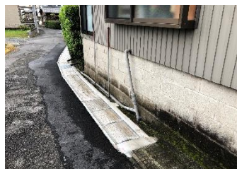
▲側溝の修繕(上深谷地内)
