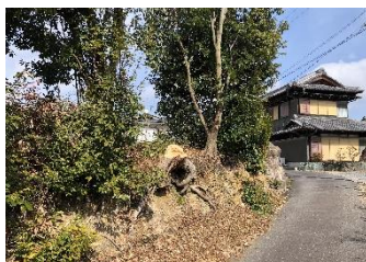
▲大木の伐採(嘉例川地内)
