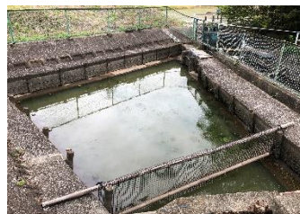
▲ポンプ施設の修繕(五反田地内)
