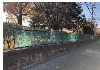
▲防砂ネットの設置(益世小)
