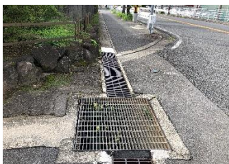
▲側溝の修繕(桑名高校南)
