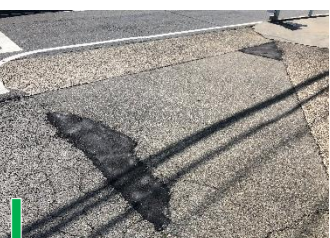
市道の維持管理(舗装補修)に対応(市内各所)
