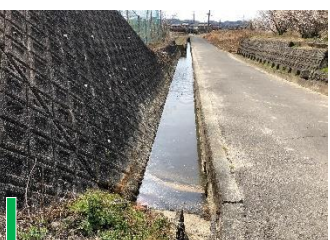
水路の維持管理(土砂撤去)に対応(額田地内)
