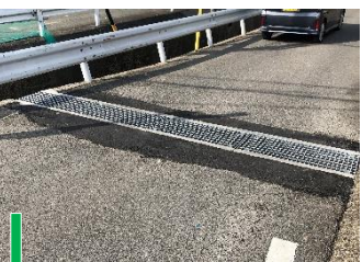
浸水対策のためのU字溝設置に対応(五反田地内)
