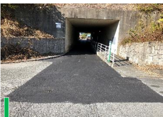
市道の維持管理(舗装修繕)に対応(福祉センター東進入路)
