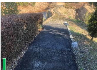
市道の維持管理(舗装修繕)に対応(嘉例川地内)
